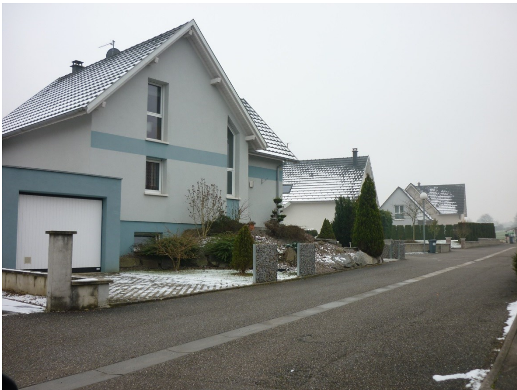
Lotissement de pavillons individuels à Aspach-Michelbach
