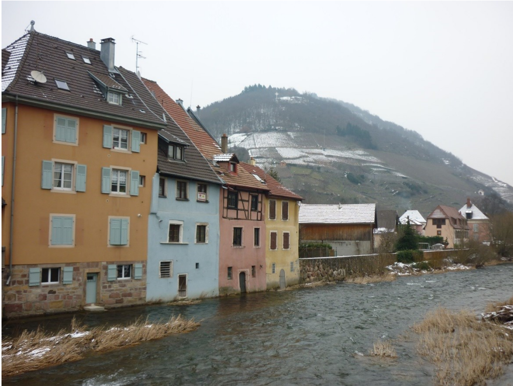
Collectifs anciens (avant 1949) sur les rives de la Thur – Centre-Ville de Thann
