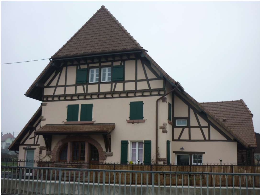
Ex : Réhabilitation d'une ancienne maison en petits collectifs (2 logts) – Aspach-le-Bas
