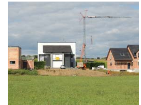
Maisons en construction à Steinbrunn-le-Bas.
