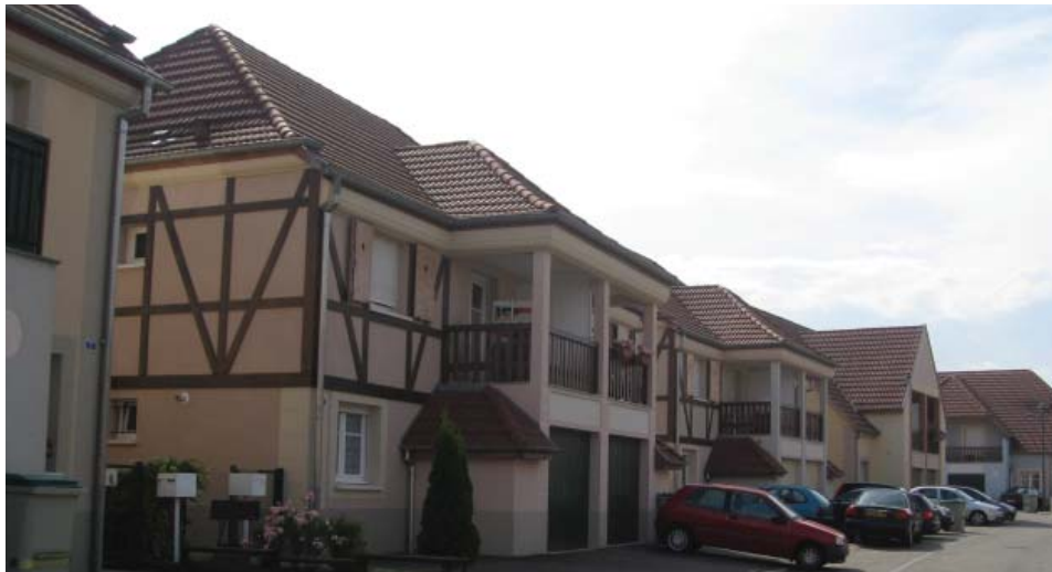
Le quartier du Kirchberg, à Morschwiller-le-Bas. Il est compte 28 logements sociaux appartenant à Immobilière 3F. L'architecture des bâtiments s'inspire des maisons alsaciennes à colombages.
